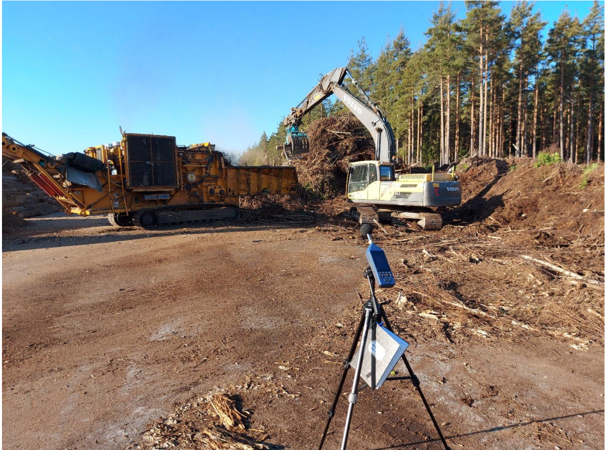
Kuva 4.1.4. Melupäästömittauksen aikana käytössä ollut murskauslaitteisto
